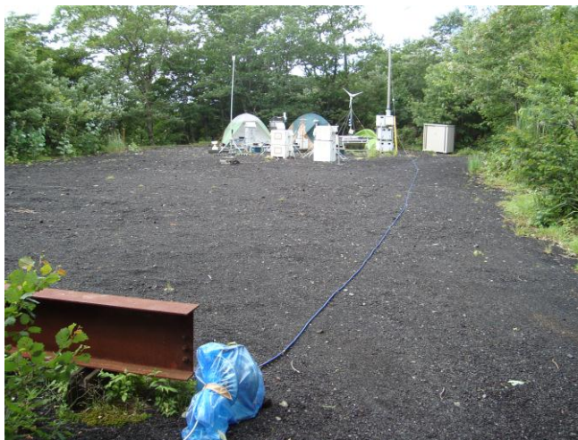
Photo 2 電源ケーブルリール
